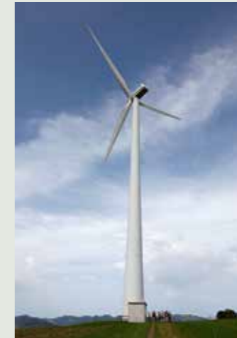
Energie aus 60 Metern Höhe.
