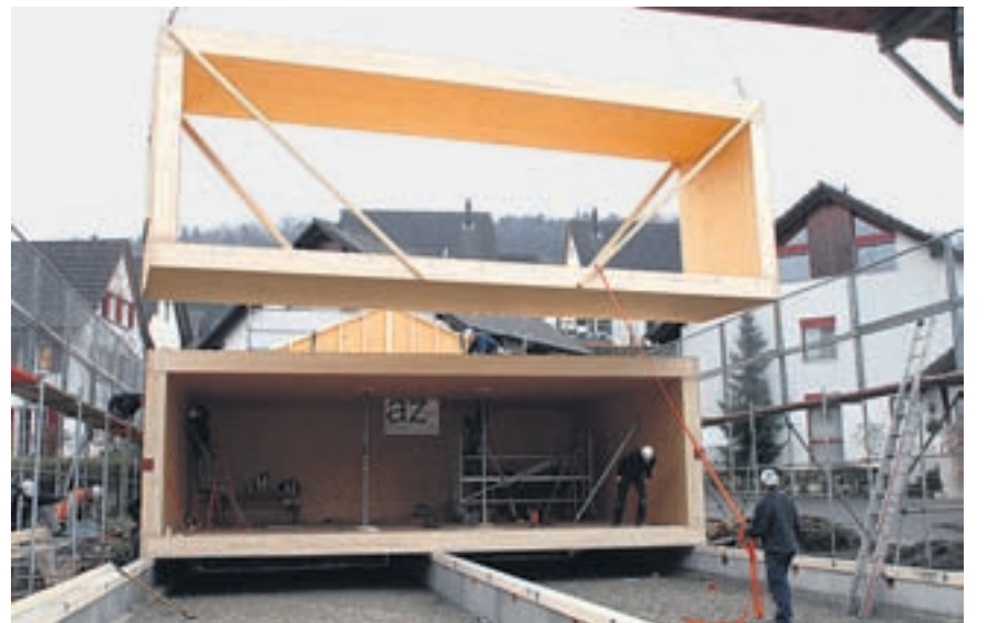
Baukastenprinzip. Der neue Laden besteht aus neun Modulen. Foto Elena Monti
